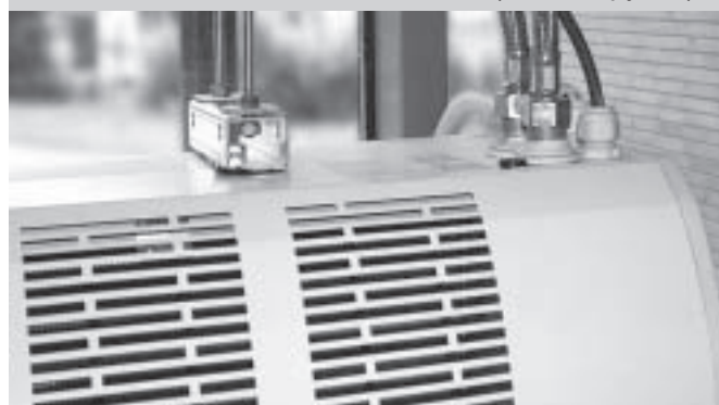
Рис. 13 – подключение отоп. воды (гибкие трубки)
